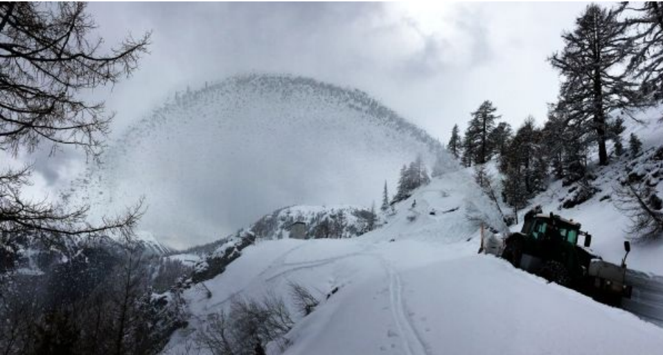
Schneeräumung der Zufahrtsstrasse zum Stausee Lac d'Émosson (Finhaut / Salvan, VS). Im Südost orientierten Hang ist ein kleiner Böschungsrutsch abgegangen (Foto: J.L. Lugon, 25.04.2016).
