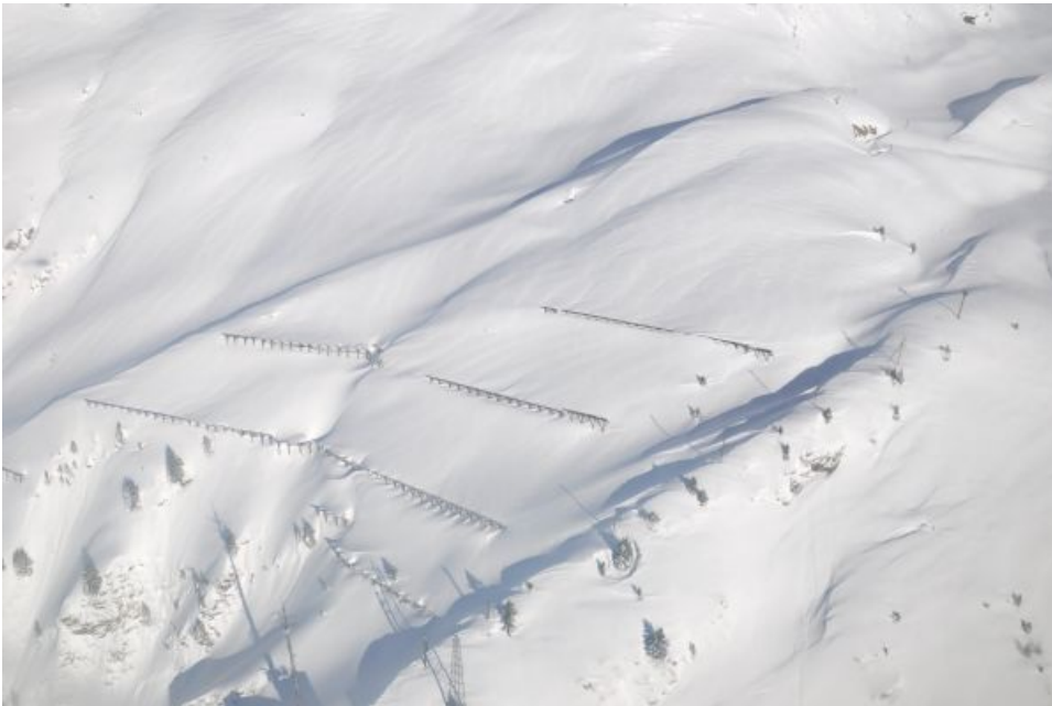
Abb. 6: Auf der Alpe di Pontino oberhalb von Airolo, TI schauten Lawinverbauungen am Dienstag, 11.02. nicht mehr viel aus dem Schnee heraus (Foto: SBB/C. Ginsig).
