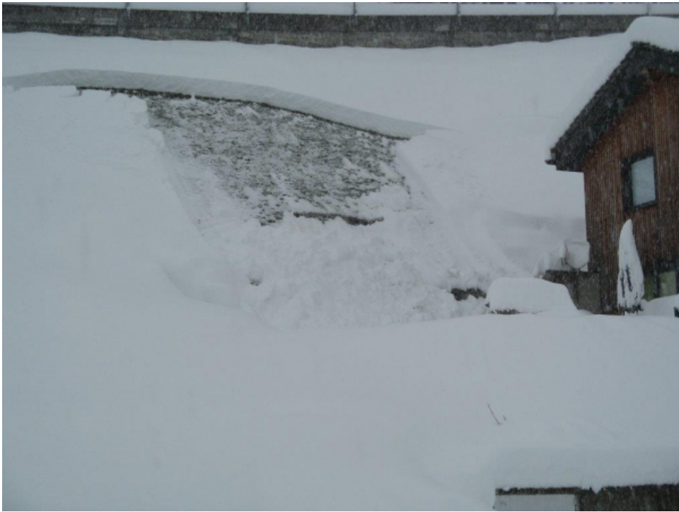
Abb. 6: Dort wo grosse Neuschneemengen auf steile, aperne Wiesen fiel lösten sich in mittleren Lagen der gesamte Neuschnee an vielen steilen Böschungen und Hängen als Gleitschneerutsch. Die 60 cm Neuschnee, die in Vals (GR) auf 1260 m am 20.04.2013 morgens gemessen wurden, rutschten noch am gleichen Tag an steilen Böschungen und Wiesenhängen als Gleitschneerutsche ab (Foto: U. Berni, 20.04.2013).
