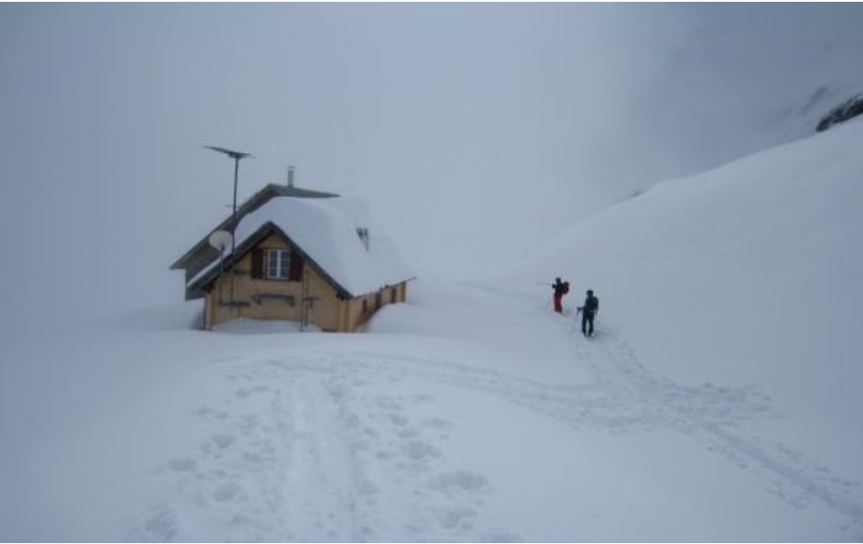
Die Gaulhütte (2205 m) in winterlichem Kleid (Foto: E. Frei, 31.03.2013).
