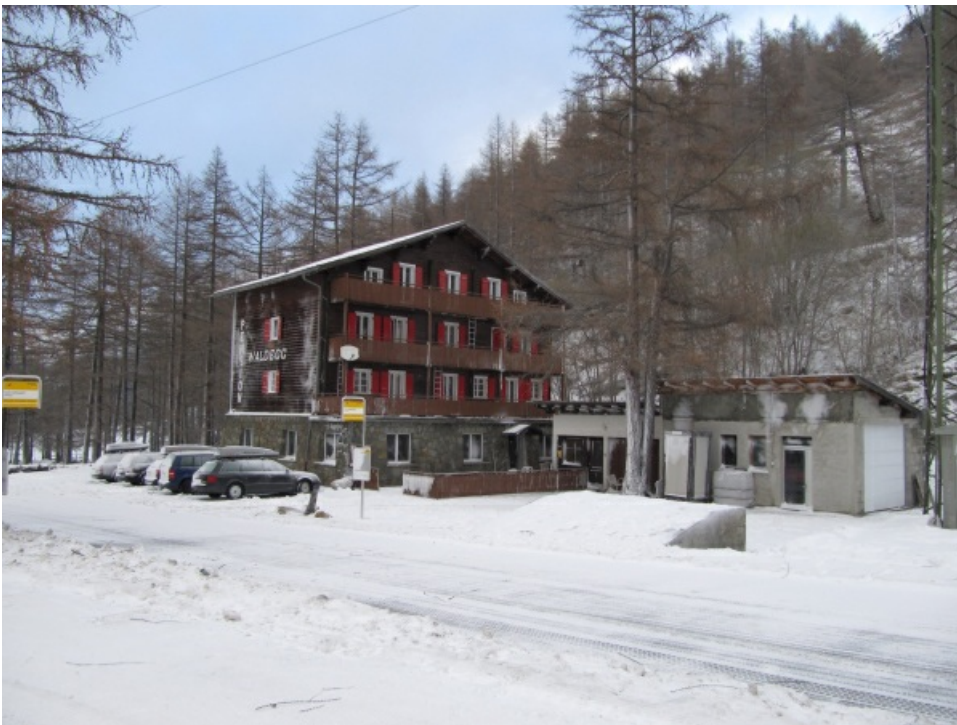
Am Freitag Morgen, 18.03. löste sich im steilen Brandgraben bei Saas-Almagell, VS eine Lawine, deren Staubanteil das Tal erreichte. Die Strasse war gesperrt, da im Gebiet wurden zur gleichen Zeit Sicherheitsprengungen durchgeführt wurden. Ob dadurch die Lawine im Brandgraben fernausgelöst wurde oder ob sie spontan niederging ist unklar (Foto: U. Andenmatten, 18.03.2011).
