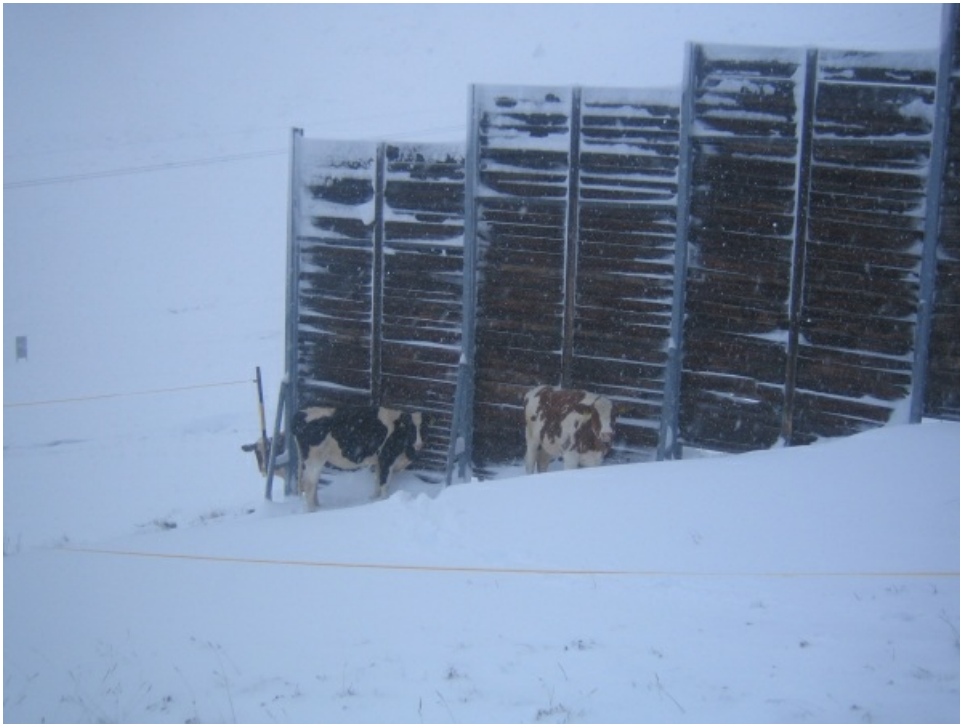
Abb. 7: Im Winter schützt diese Holzwand das Trassee der Parsennbahn (Davos, GR) vor Schneeverwehungen. Am letzten Tag des meteorologischen Sommers suchten die Rinder ihren Schutz. Eine Stunde später war Alpbefahrt (Foto: SLF/F. Krumm, 31.8.2010).
