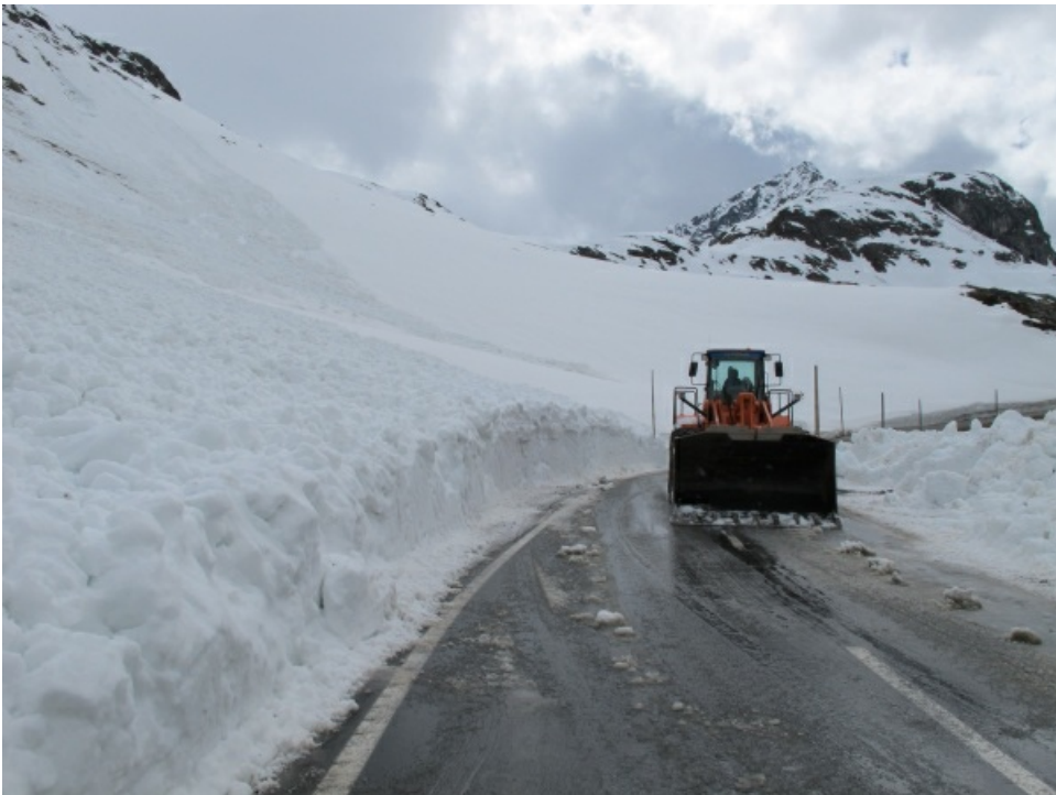
Von der Räumequipe wurde die Ablagerung dieser Nassschneelawine mit einem zähflüssigen Brei verglichen. Die Lawine konnte vermutlich auf Grund des hohen Wassergehaltes relativ weit fließen. Flüelapassstrasse oberhalb von Chant Sura, Susch, GR (Foto: J. Rocco, 10.05.2010).
