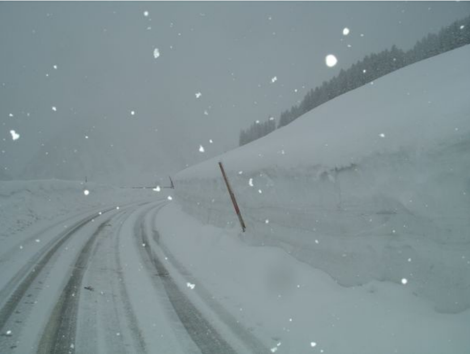
Kriechbewegung der mächtigen Schneedecke trotz wenig steilem Gelände. Ein Beispiel an der Strassenböschung von Elm nach Wichlenalp auf der Höhe Büel, GL (Foto: SLF/HU. Rhyner, 26.03.2009)
