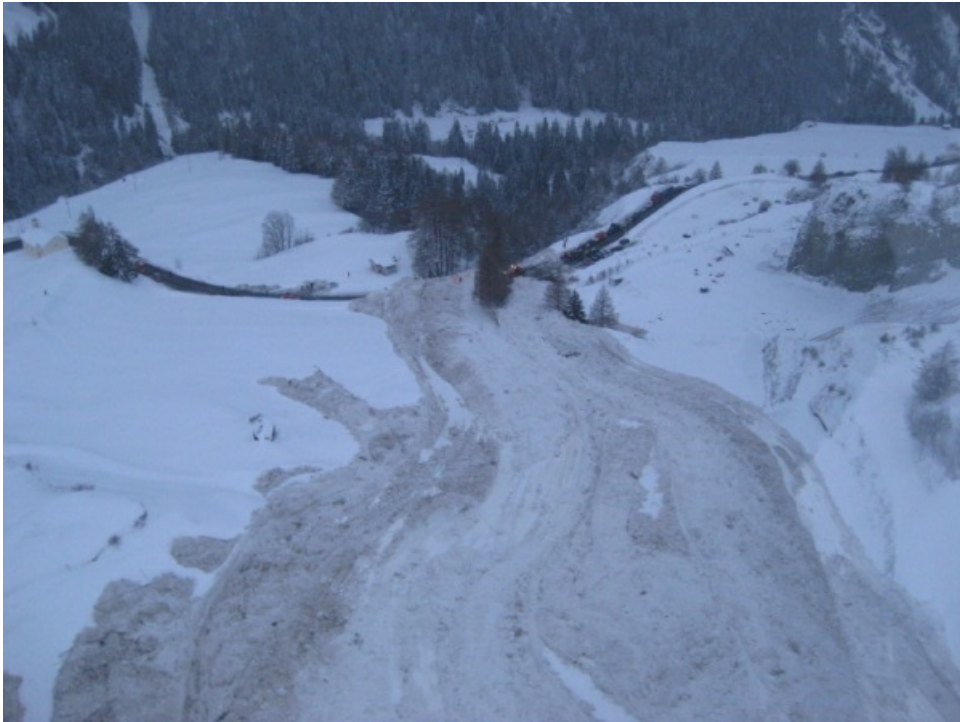
Abb. 1: Spontane Lawine, die sich oberhalb des Torrent d'Aron auf rund 2500 m an einem Nordwesthang löste und grosse Ausmasse annahm. Die Passstrasse des Grossen St. Bernhard wurde bei Liddes, VS und auf einer Breite von rund 40 m verschüttet (Photo: E. Berclaz, 06.03.2009).
