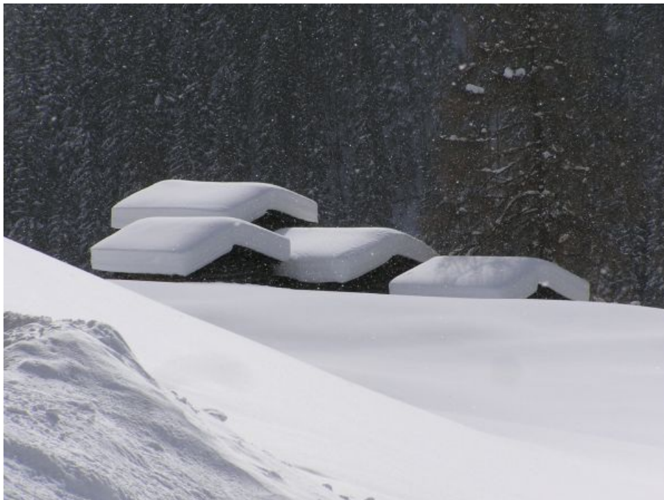
Abb. 7: Tief verschneite Landschaft im Raum Davos mit erheblichen Dachlasten auf alten Monsteiner Spychern (Photo: SLF/C.Pielmeier, 18.02.2009)
