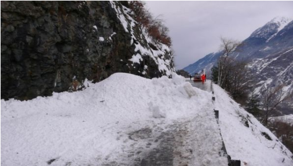
Glissement de neige humide sur la route de Salvan entre Martigny et Gueuroz, VS, 600 m vers 15h45 samedi, 24.01. (Photo: J.-L. Lugon).
