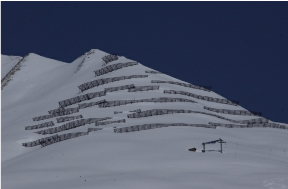
Teilweise eingeschneite Lawinverbauungen oberhalb von Elm, GL (Foto: R. Rhyner).
