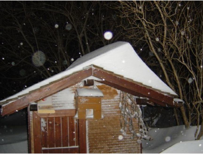
Tribschneeansammlungen auf Dach. Der Wind wehte von links nach rechts und führte zu asymmetrischer Schneeeablagerung (Foto: P. Diener, 09.02.2006, Toggenburg).
