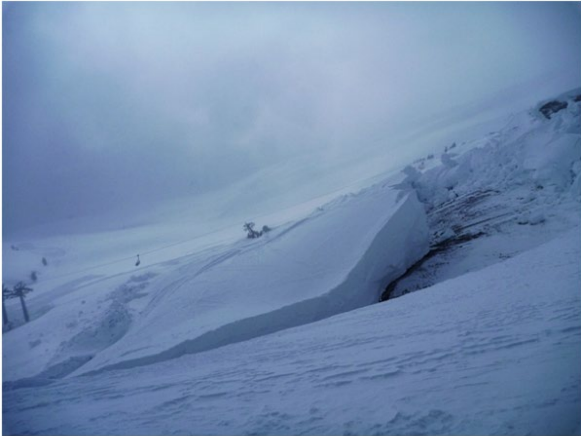
Photo 4 : Un ouvrage, par exemple une fondation de pylône, qui se trouve dans la zone où le manteau glisse, est soumis à des forces de pression très importantes. Sur le télésiège de Lungern – Schönbühl, un pylône a été renversé. La pression résultante exercée par la neige a dû dépasser 100 tonnes. Le manteau pouvant atteindre 8 m d'épaisseur s'est déplacé d'environ 25 m vers l'aval (7 février 2012 ; photo SLF/S. Margreth)
