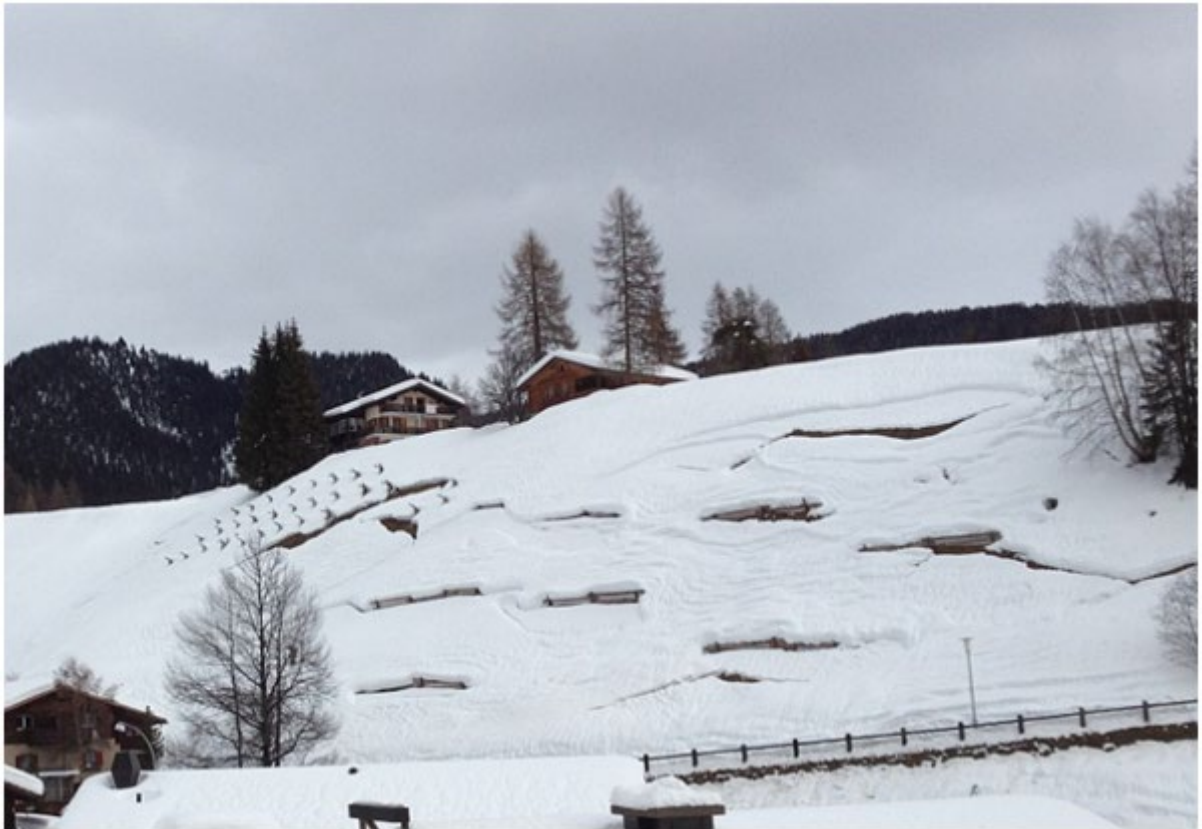
Photo 5 : Les glissements peuvent être entravés par des ouvrages appropriés, comme des tripodes ou des ouvrages de retenue. Dans le contexte présenté, aucune avalanche de glissement ne s'est déclenchée dans les zones équipées (Wiesen, janvier 2012 ; photo SLF/S. Margreth)
